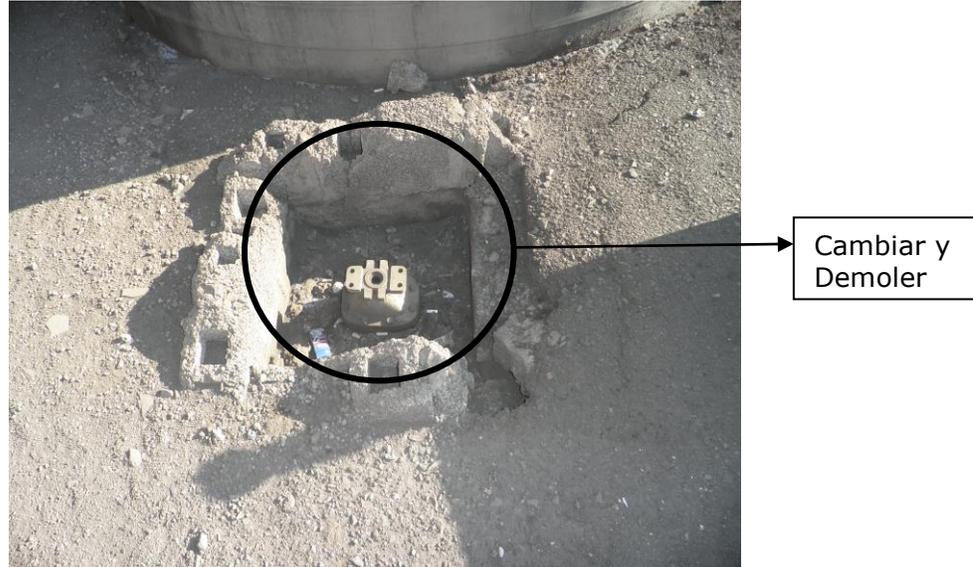
**3.5.2.- Válvula de Corte.-** Esta se encuentra al interior del estanque en la parte superior y controla que el estanque no se rebalse, deberá reemplazarse esta válvula por una de similares características de acuerdo al diámetro de la cañería, además debe reemplazarse válvula de corte manual que está ubicada a 1,2 mts del piso a un costado del estanque la que deberá cambiarse por una similar junto con cañerías involucradas en esta instalación conservando las medidas existentes (2”).
